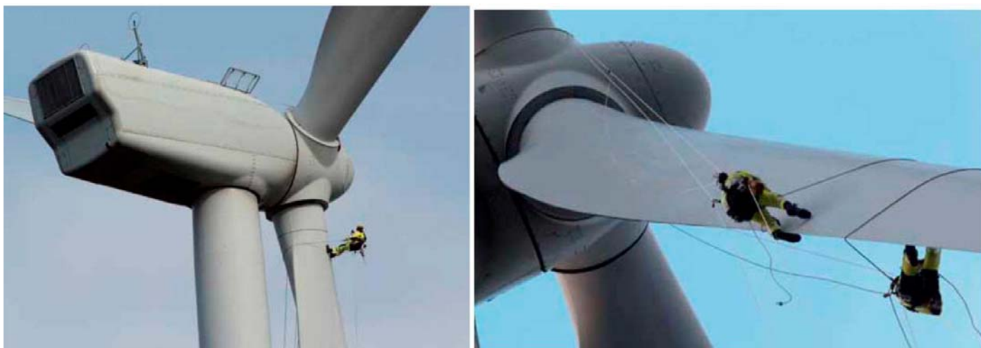
Figura 2. Ejemplos de trabajos verticales en un aerogenerador (Fuente: Guía para el uso de cuerdas en trabajos verticales de AEE).
